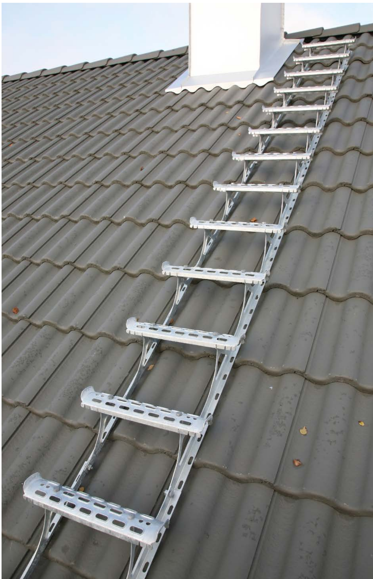
Universalstege på tak med betongpannor.
