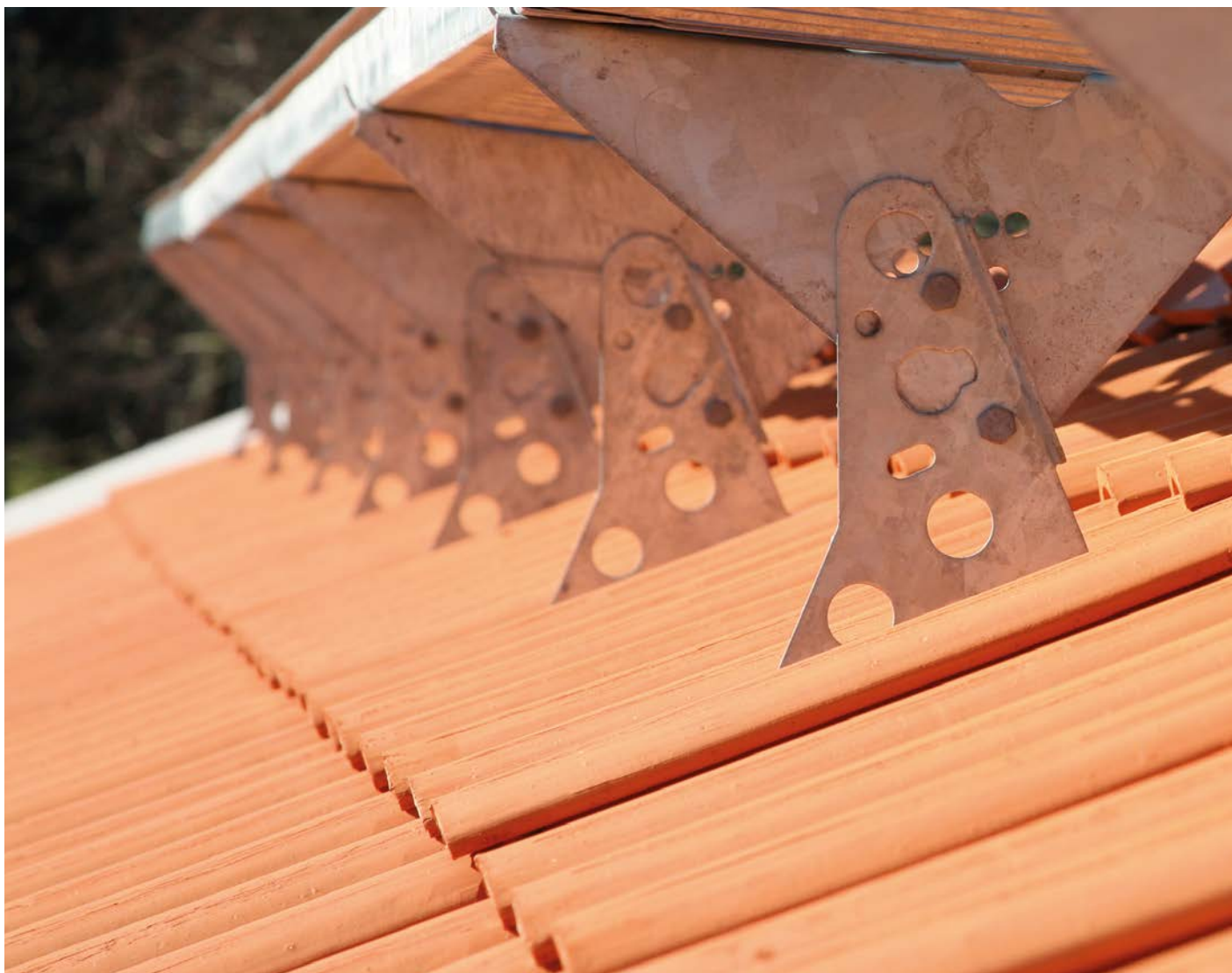
Konsol med bryggfäste på lertegeltak.
