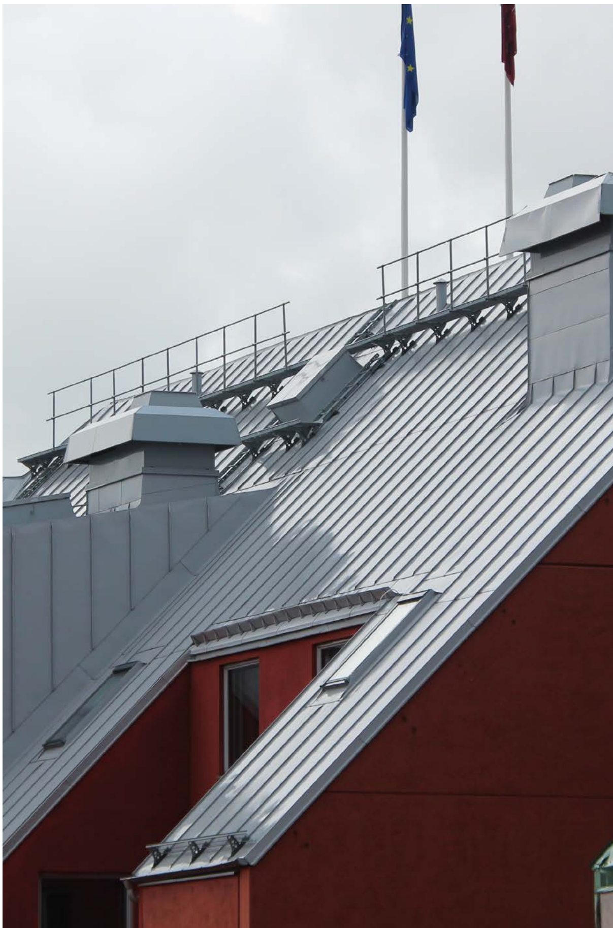
Takbrygga med skyddsräcke 1100 mm.
