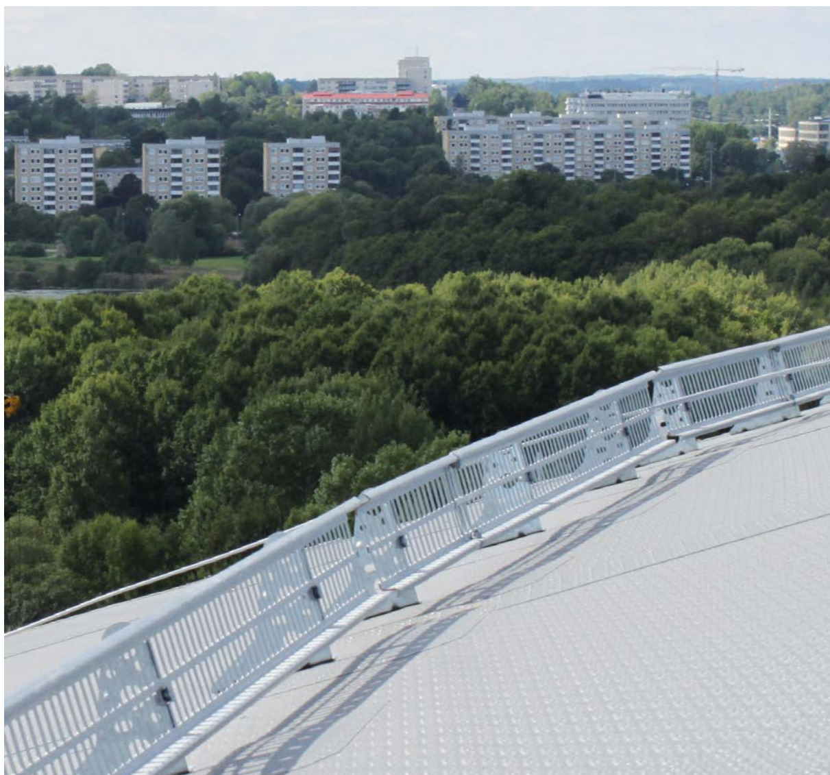
Snörasskydd monterat på slät tätplåt.
