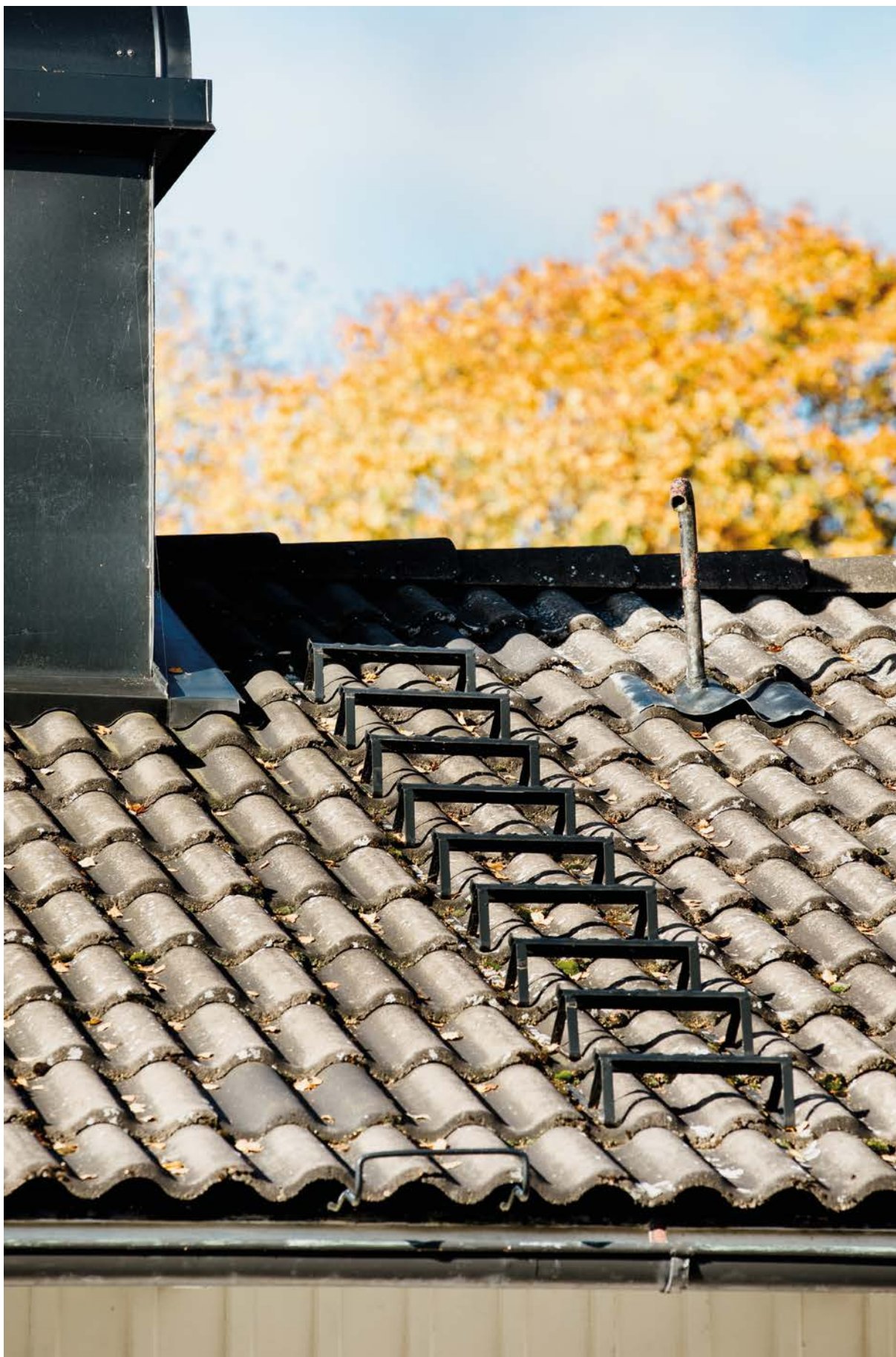
Taksteg på tak med betongpannor.
