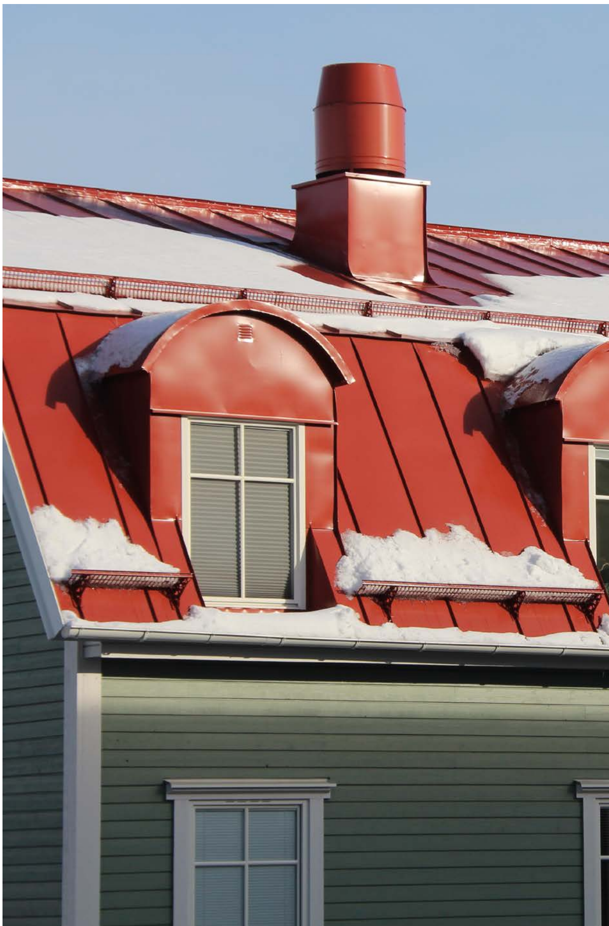
Snörasskydd i profildurk med falsfästen.
