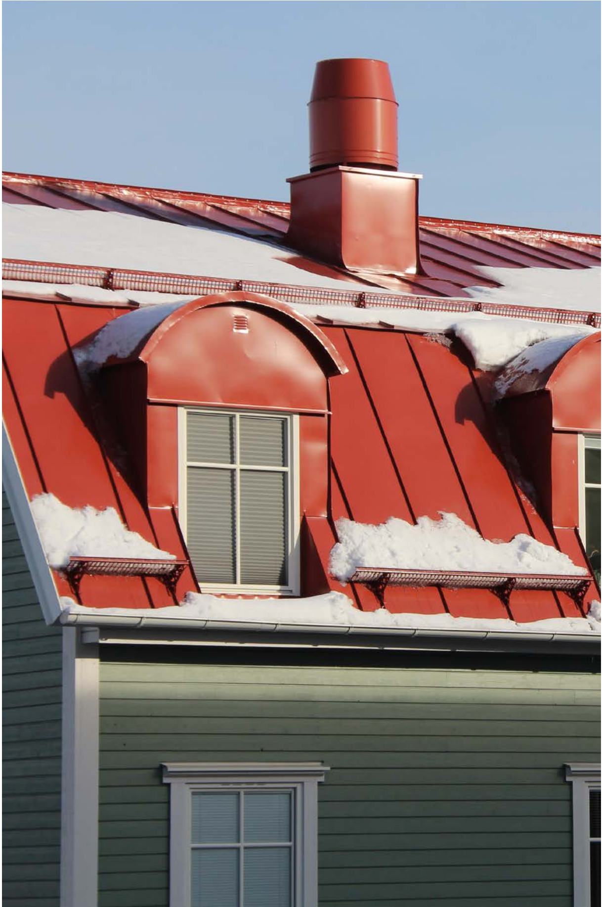
Snörasskydd i profildurk med falsfästen.
