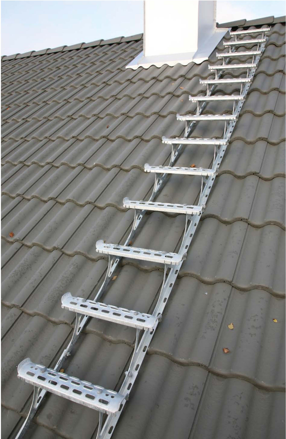
Universalstege på tak med betongpannor.
