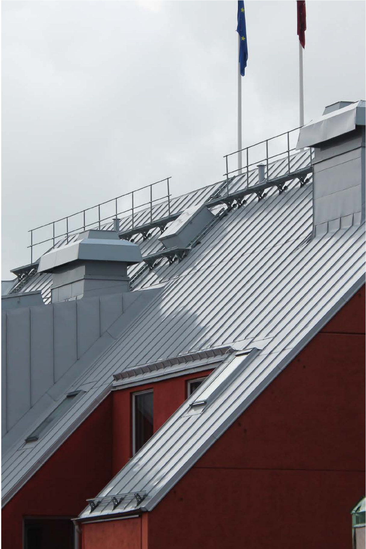
Takbrygga med skyddsräcke 1100 mm.
